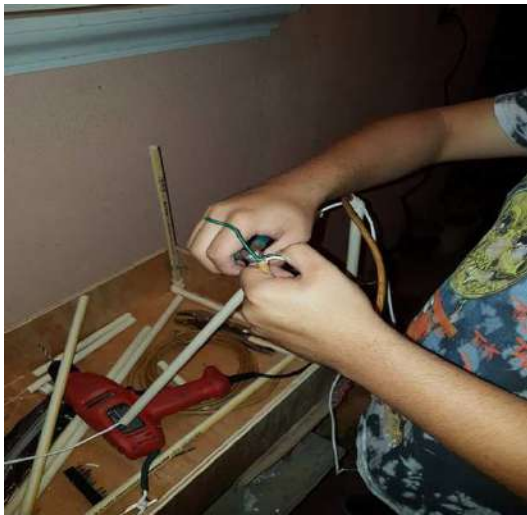
Imagen 3. Instalación del cableado en los tubos de PVC para el sensor de humedad, de temperatura, para la energía del foco, del ventilador y de la bomba de agua para circular el agua por las mangueras.
