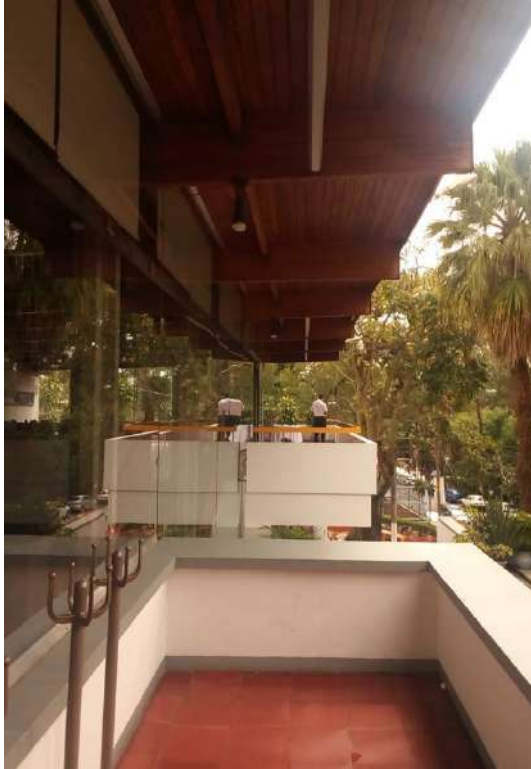
Figura 4. Restaurante La pérgola. Enrique Murillo.
