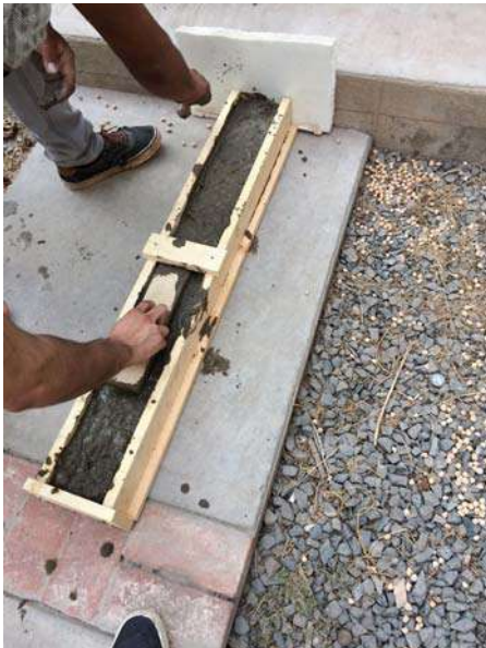
Imagen 2. Colado de los canales.
