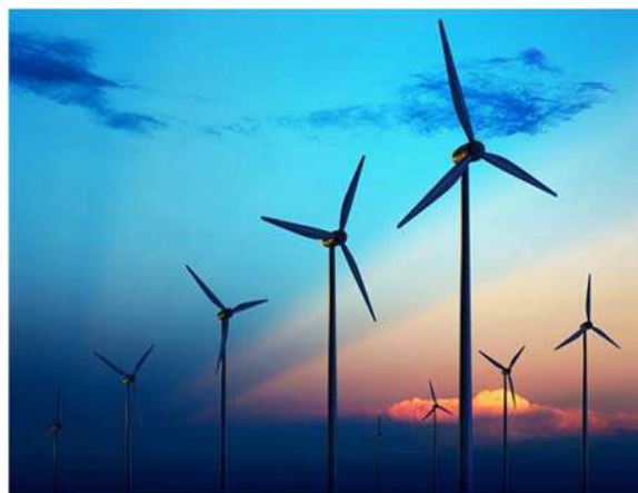
Figura 1, Torres de viento generadores de energía eléctrica, colocadas en el valle de Mexicali.
