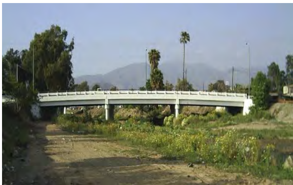
Figura 7 Fotografía tomada aguas abajo del puente sobre la calle 9 en Ensenada Baja California [2].
