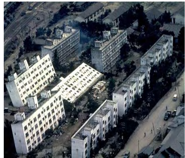
Figura 4 Fotografía tomada por Karl Steinbrugge de un conjunto de edificios que sufrieron daños debido a que existió licuación del terreno donde se cimentaban en Niigata, Japón en 1964 [4].
