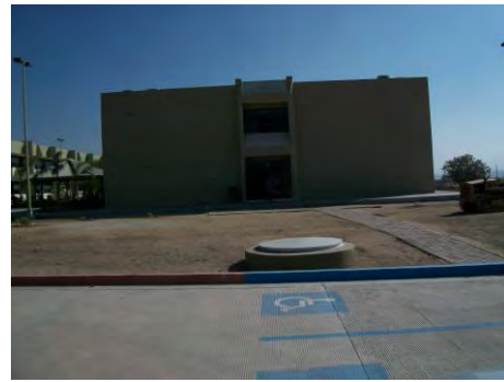
Figura 6. Fotografía exterior del edificio en donde se colocó el acelerómetro.
