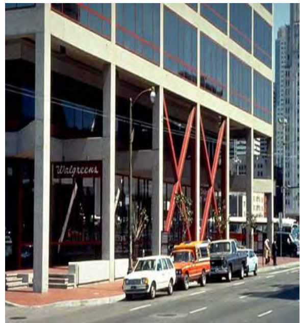
Figura 5 Fotografía de un edificio con contraventeo en cruz.
