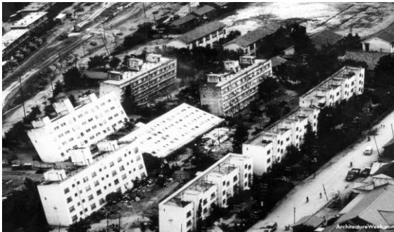
Figura 4. Edificaciones destruidas durante el terremoto de Niigata en 1964. (Fuente: http://es.wikipedia.org/wiki/Licuefacci_de_suelo#mediaviewer/File:Niigata_soil_liquefaction.jpg )
