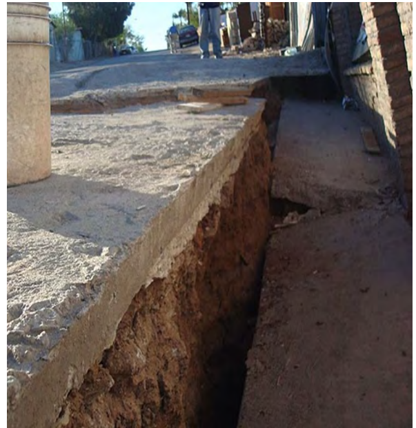
Figura 7. Asentamiento de banquetas. (Fuente: Armando R. Lara Valle (Gobierno de Baja California))
