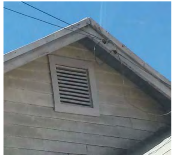
Figura 6. Ejemplo de ventilas entre plafón y cubierta. Foto 2013
