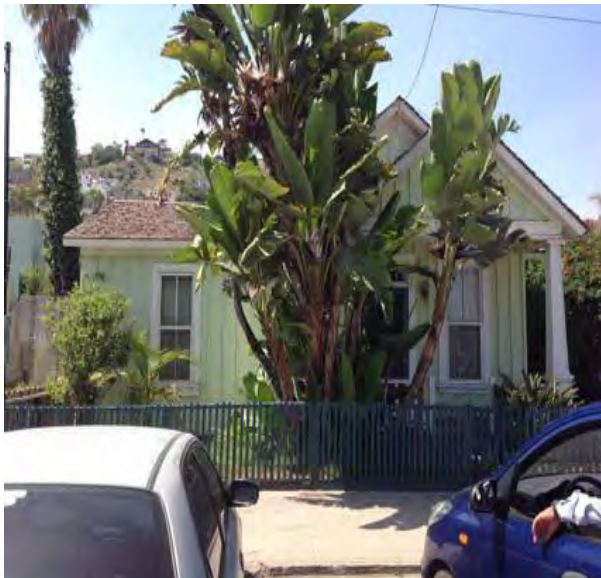
Figura 3. Vivienda tradicional. Foto 2013
