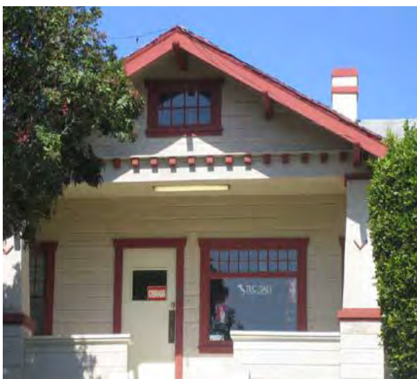
Figura 5. Vivienda tradicional. Foto 2013
