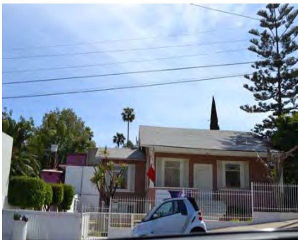
Figura 4. Vivienda tradicional. Foto 2013
