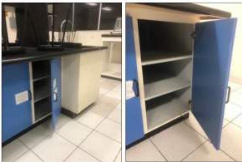
Figura 37.- Puertas de muebles de alas 1 y 2 del Laboratorio de Usos Múltiples después de la reparación de bisagras.
