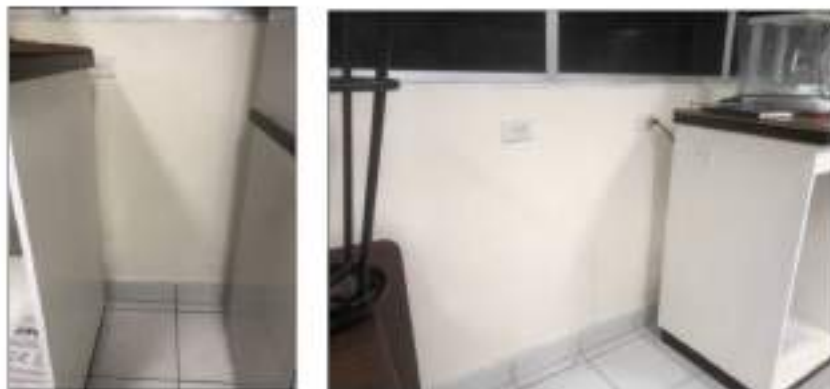
Figura 35.- Detalle del mantenimiento de pintura en muro del Laboratorio de Usos Múltiples.
