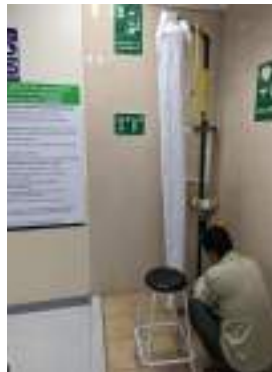
Figura 49.- Mantenimiento y purga de la regadera de emergencia del Laboratorio Bio 2.
