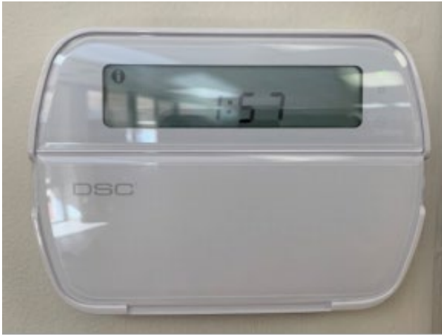
A 56.- Módulo de control de Alarma.
