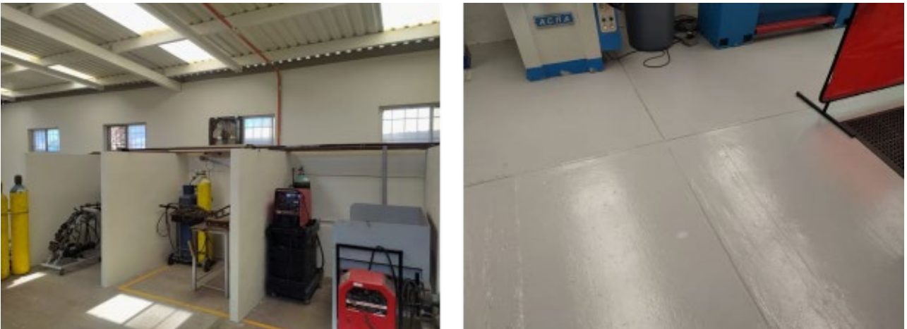
A 21.- Detalles de los trabajos de pintura en techo metálico y aplicación de pintura epoxica industrial en el Laboratorio de Máquinas Herramientas.
