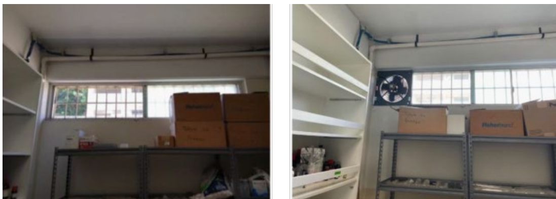
A 42.- Extractor de aire, a) antes de la instalación y b) después de la instalación.
