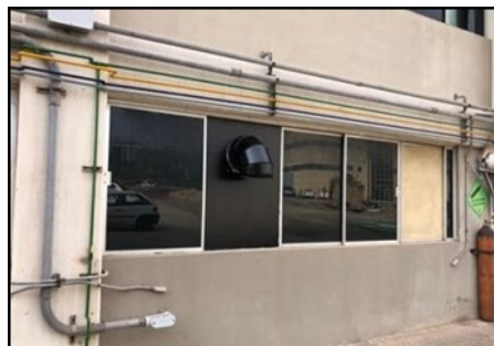
A 36.- Tubo en U de aluminio, instalado al exterior del almacén del laboratorio de Química.
