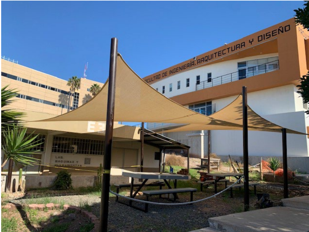
A 11.- Instalación de malla-sombra y mesas para mayor confort de los alumnos que utilizan las áreas comunes del edificio E37.
