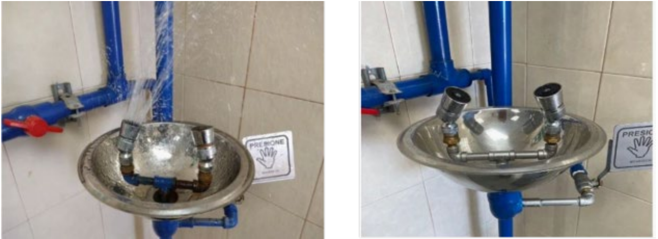
A 43.- Reparación del lavajos, a) antes y b) después.
