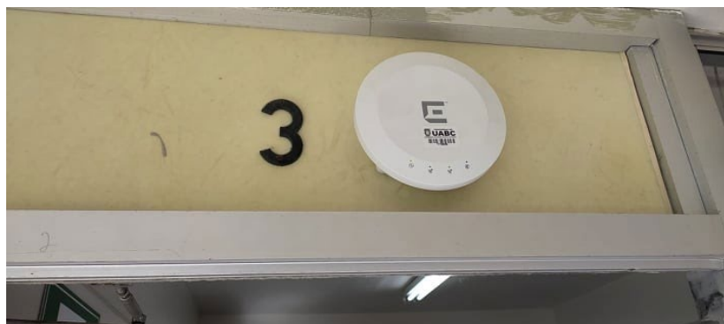
A 25.- Colocación de un nuevo punto de acceso a internet en el laboratorio de Maquinas Herramientas.
