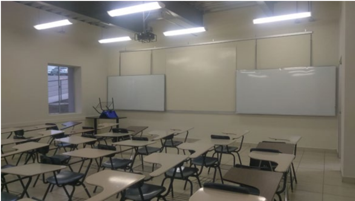
Figura A 33 . – Mantenimiento de aulas.
