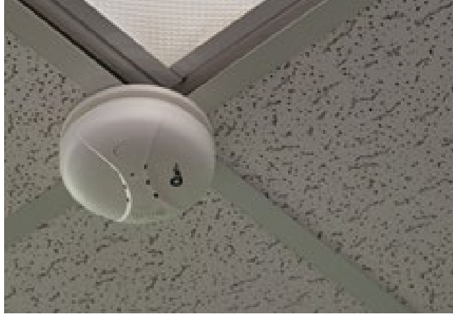
Figura A 22. – Detectores de humo.
