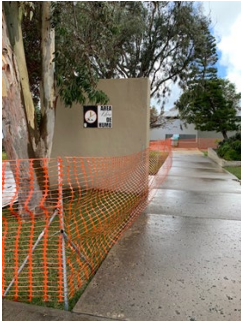
Figura A 40. – Delimitación perimetral para control de acceso a las instalaciones de la FIAD.
