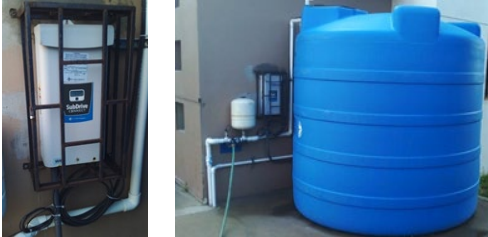
Figura A 28. – Instalación de protección en tablero de control.
