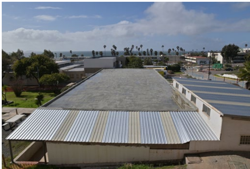
Figura A 31. – Reparación del techo Laboratorio de Máquinas y Herramientas.
