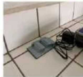
Ilustración 23. Tomacorriente instalado (Después)
