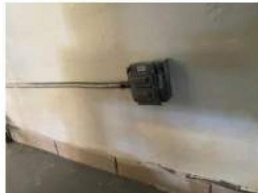
Ilustración 17. Pared resanada y pintada (Después)
