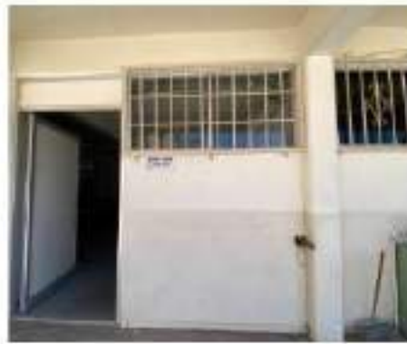
Ilustración 27. Reja de seguridad colocada
