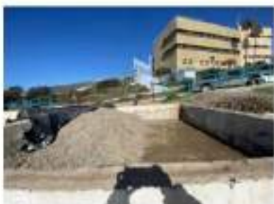
Ilustración 10. Banco de materiales (Antes)
