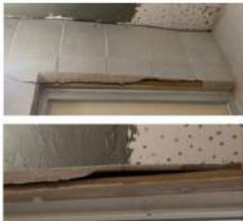
Ilustración 18. Cuarto de curado (Antes)
