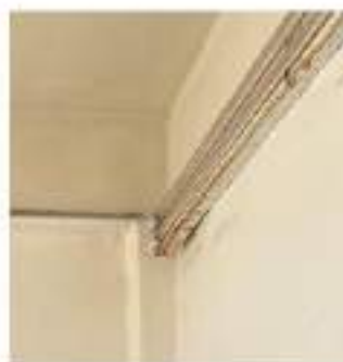
Ilustración 13. Paredes reparadas (Después)
