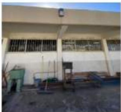
Ilustración 14. Luminaria del patio trasero (Antes)
